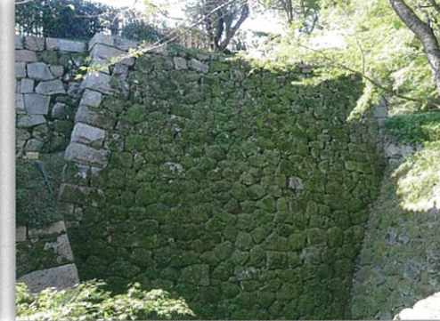
④ 本丸大手南袖石垣 □ 城内で最も高い石垣です。高さ約11mを測ります。左右の石垣と複雑に折り重なっています。
