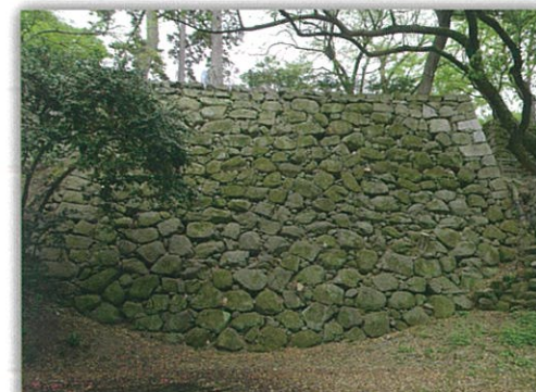
⑪ 埋門北袖石垣 □ 築石に大きい石材(自然石と割石)を使っており、高さも10mを超す立派な石垣です。
