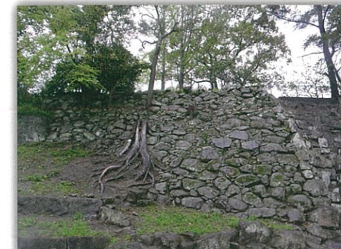
⑲ 二の丸南東石垣 □ 自然石を用いて積み、間詰め石には川原石と花崗岩がみられる古い様相を示す石垣です。
