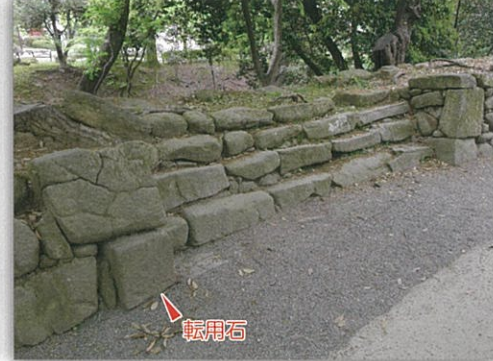
② 持仏堂曲輪の雁木 □ 岡崎城跡内では数少ない雁木(石階段)です。城内で唯一の転用石(墓石)が使用されています。
