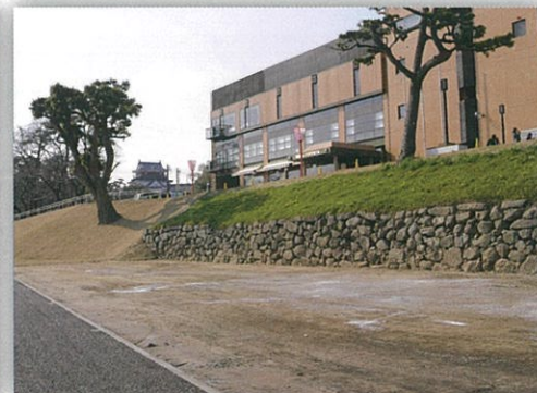
⑰ 菅生川端石垣 □ 菅生川沿いの石垣で、発掘調査により全長400m、高さ5.4mにも及ぶことが分かりました。城外郭の防衛、治水の役割がありました。
