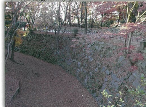
③ 清海堀石垣 □ 曲線状の深い堀を構成する石垣です。一部に天守台に次ぐような古い石垣が残っています。
