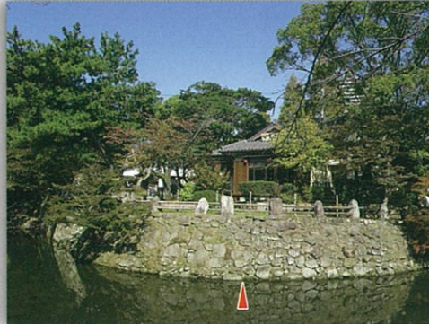
⑮ 隠居曲輪石垣 □ 絵図に描かれたとおり、半円形の曲輪を構成する石垣です。石垣は何度も補修された痕跡が残ります。幕末に石垣が崩れた記録があり、明治時代の古写真にも崩れた状態で写っており、同時代に補修されています。
