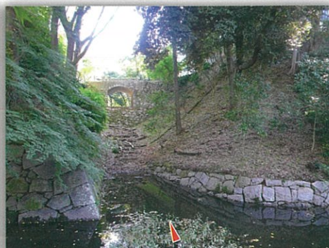
⑫ 持仏堂曲輪腰巻石垣(左)と本丸腰巻石垣(右) □ 絵図に描かれたとおり、持仏堂曲輪腰巻石垣の隅角部は直角に、本丸腰巻石垣は曲線状に曲がります。奥には本丸から持仏堂曲輪へつながる廊下橋の石垣も見ることができます。
