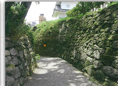
⑳ 南切通し石垣 □ 堀底を道として利用したもので、S字状に曲がります。東隅櫓からの横矢がかかる(敵の側面から矢を射る)構造となっています。
